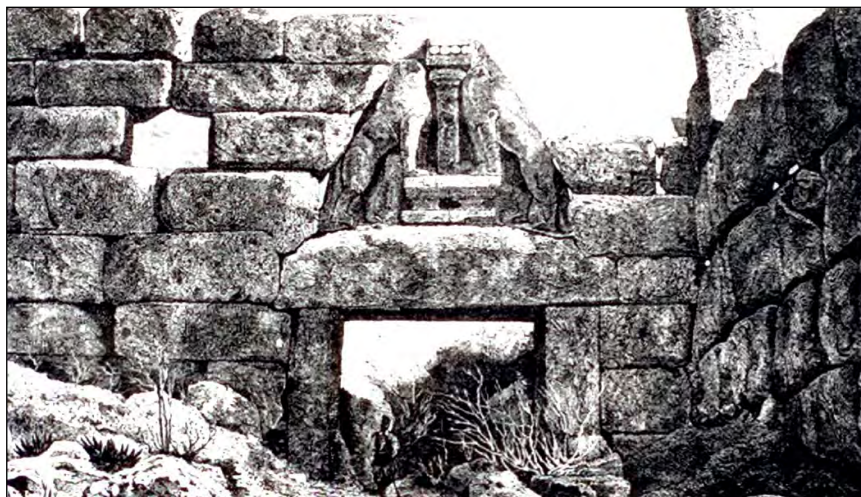
Porte des lionnes, à Mycènes, voir les murs aux gros blocs de pierre, caractéristiques aux constructeur pélasgiens.
